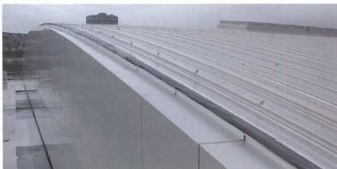
Bild 2. Dacheindeckung mit Kalzip-Aluminiumprofilen (Fotos: aTmos/Schlichter/asp)
