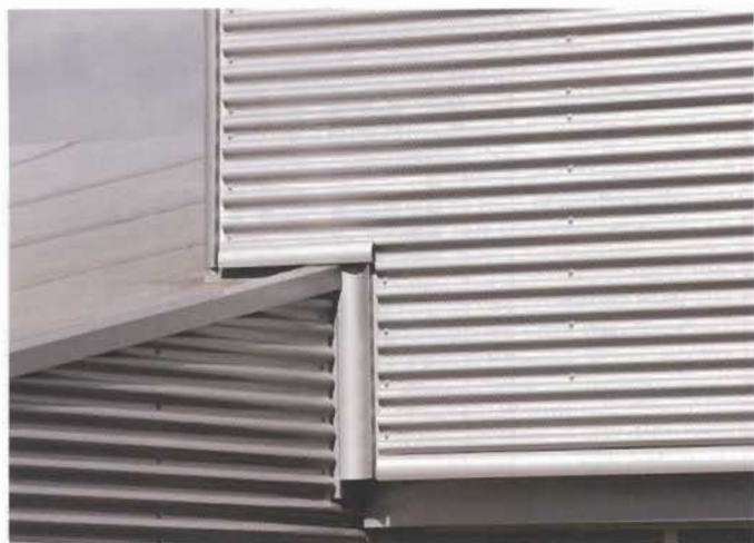
Bild 2. Detail Eckenausbildung mit Softline-Profilen
