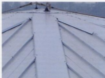
Bild 2. Im Runddach kamen Metecno Brandschutzelemente Hypertec G 158 mit Mineralwollefällung zum Einsatz (Foto: IFBS)
