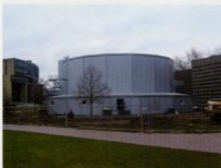
Bild 1. Die Rheinoper Mobil - eine Interimslösung, die Schule macht
