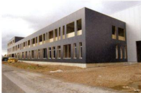
Bild 2. Fassade des Verwaltungsgebäudes aus mikrolinierten Thyssen-Isopaneelen
