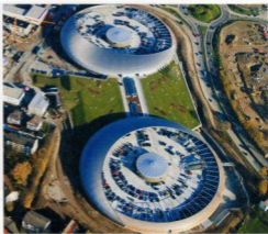
Prägt die Optik von „Shopping Cité“: eine Konstruktion aus Kalzip-Bahnen
