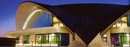
La Coque, die Muschel – Erweiterungsbau am olympischen Schwimmstadion der Stadt Luxemburg. Ausführung: Trmata s.à r.l, Luxemburg / Material: KME, Tecu-Classic Architektur: Roger Tallibert, Paris / Fotografie: Paul Metzler, Luxemburg BAUMETALL 8/2005
