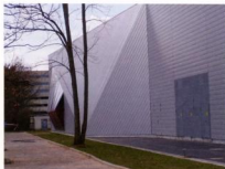
Bild 1. Die Halle verformt sich nach ihren inneren Anforderungen
