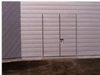
Bild 2. Die Türen sind bündig mit der Fassadenoberseite
