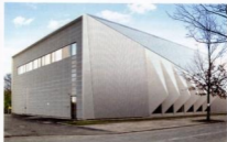
Bild 2. Die freistehenden, senkrechten Sonnenschutzlamellen werden Klemen genannt (Foto: Radabau/Architekten 54)
