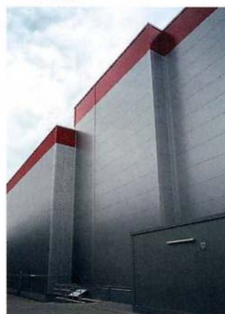
Bild 2. Die Fassade des Hochregallagers besteht aus Mineralfaser-Sandwichelementen; als Abschluss im oberen Bereich der Fassade wurde ein rotes Farbband platziert (Fotos: Hammersen Elementbau)
