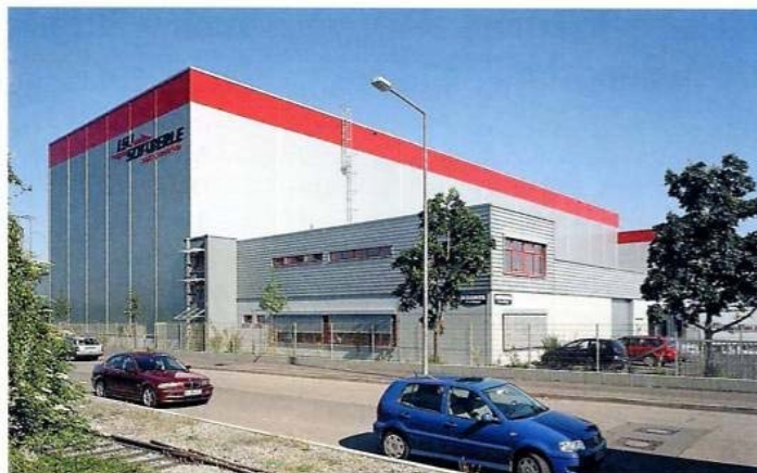
Bild 1. Die neue Logistikhalle des Unternehmens LSU Schäberle in Stuttgart
