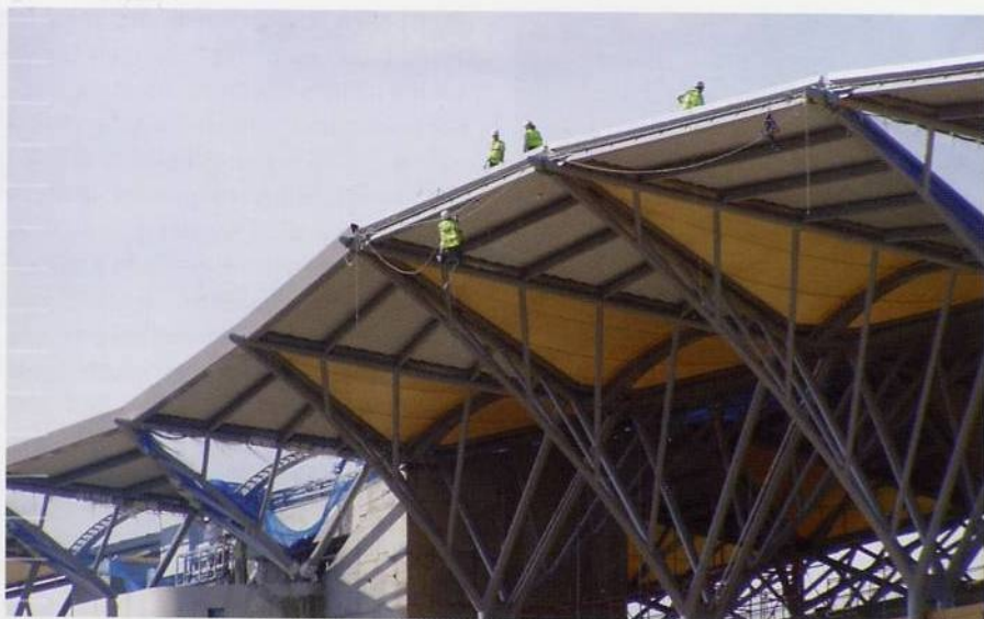
Das Dachtragwerk umfasste eine 1500 Tonnen schwere Stahlkonstruktion. Die einzelnen Stahlkonstruktionsteile wogen bis zu 15 Tonnen und hatten Außenabmessungen von bis zu 34 m Länge x 12 m Breite und eine Höhe von bis zu 11 m.
