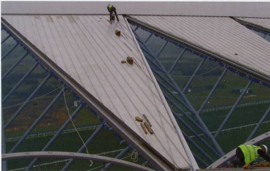
Für die Montage entwickelte man spezielle Montageschablonen, mit denen die vorgefertigten Elemente präzise unter Einhaltung der engen Toleranzvorgaben an der Baustelle zusammen gebaut wurden.
