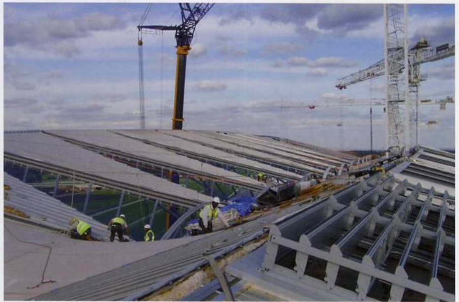
Die Dacheindeckung besteht aus einzelnen Baufeldern mit einem doppelschaligen Metaldach und Folienkissen.
