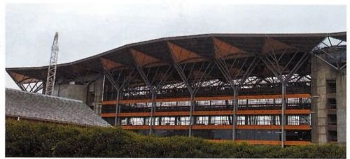
Bild 3. Seitenansicht des Bereiches 2
