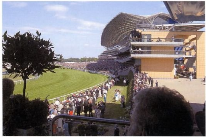
Bild 1. Ascot Racecourse mit dem neuen Tribündach aus Stahlleichtbauelementen
