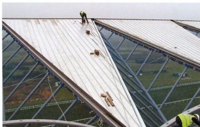
Bild 5. Für die Montage wurden spezielle Montageschablonen entwickelt, mit denen die vorgefertigten Elemente präzise unter Einhaltung der engen Toleranzvorgaben an der Baustelle zusammengebaut wurden (Fotos: Radabau/Wagner-Biro)
