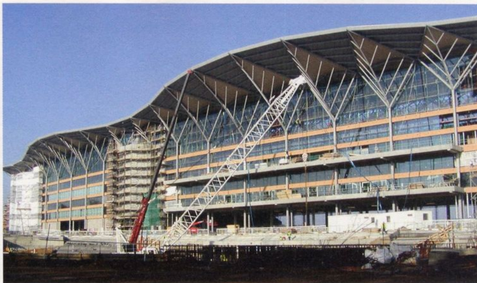
Das Dachtragwerk umfasste eine 1500 Tonnen schwere Stahlkonstruktion
