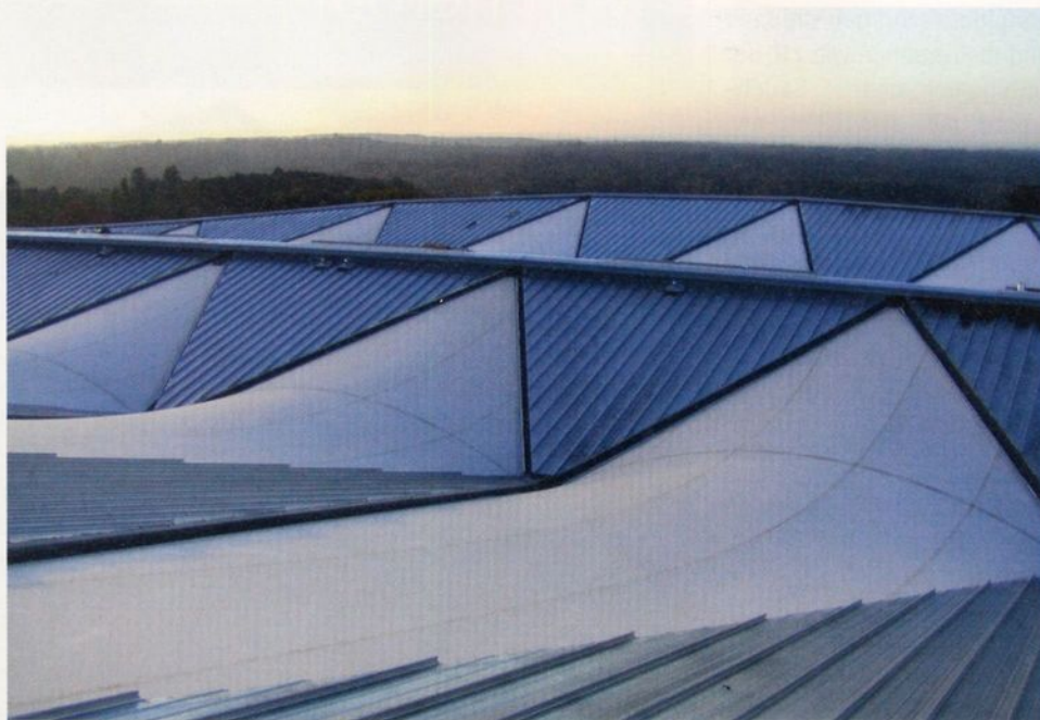
Obwohl alle Elemente ähnlich scheinen, sind alle Dachfelder am Projekt einzigartig
