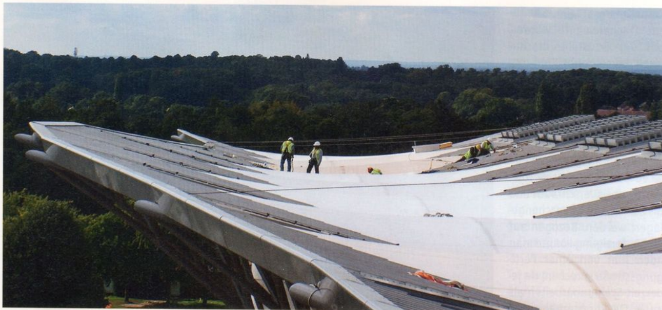
Arbeiten in luftiger Höhe: Auch mit Schutznetzen abgesichert leisteten die Monteure im Dachbereich ganze Arbeit
