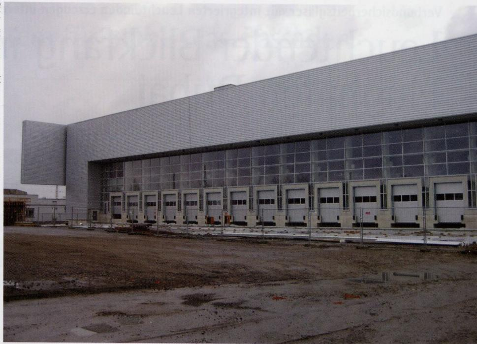
ReflectionsLume, Typ "reflection silver 1" an Kopf- und Stirnseite des Logistikzentrums.
