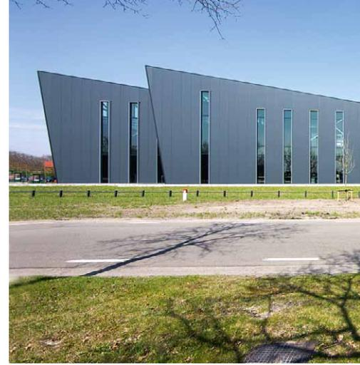
Hier zählen die inneren Werte: zwei Schalen und ein Dämmkern – Sandwichelemente bestehen aus zwei profilierten metallischen Deckschichten, zwischen denen sich ein Kern aus Hartschaum oder Mineralwolle befindet.
