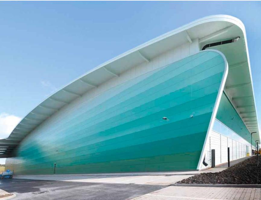
Es werden hohe Anforderungen an Hochregal-, Tiefkühl- oder sonstige Lager gestellt, die mit der Sandwichbauweise vollständig erfüllt werden. Durch das hohe Dämmvermögen der Sandwichelemente lassen sich Innentemperaturen, ganz gleich ob im Plus- oder Minusbereich, exakt einhalten. Damit wird der Energieverbrauch reduziert und besser kalkulierbar gemacht. Ebenso lassen sich mit der Verwendung von Sandwichelementen die Anforderungen einschlägiger Verordnungen (z. B. EnEV) erfüllen.
