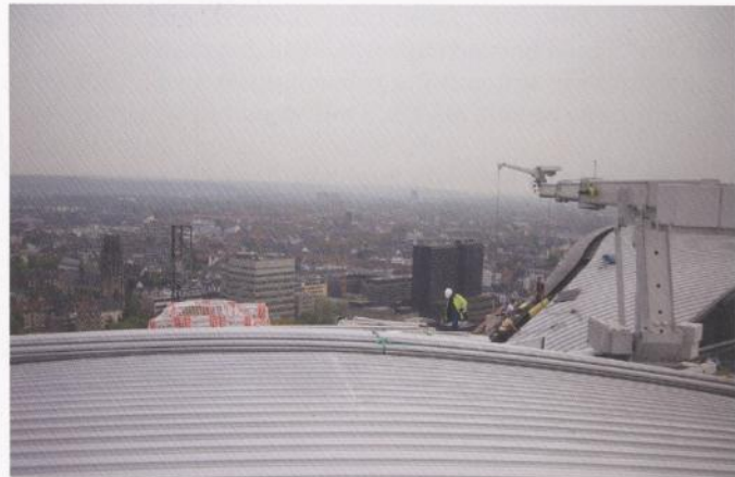
Bild 1. Das 530 mm dicke Dämmstoffpaket für das Dach des Sky Office Düsseldorf besteht aus mehreren Dämmarten: Hartmaterial, halbsteifes Material, normaler Rollfilz; in Teilbereichen wurden Bahnlängen von über 20 m montiert
