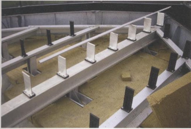
Bild 3. Die Montage erfolgte in enger Zusammenarbeit mit dem Hersteller der Kalzip-Bahnen (Fotos/Grafik: B. Schlichter)
