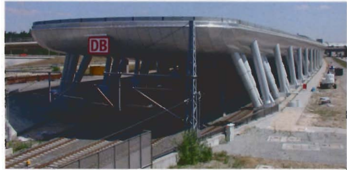
Bugansicht nachher mit Verkleidung aus Trapezprofilen und exaktem Fugenverlauf. Die Fluchtilinten waren exakt einzuhalten.
