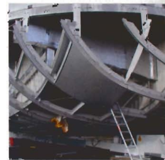
Bugansicht vorher: Die Zwischenbinder bestehen aus 15 einzelnen Radian.
