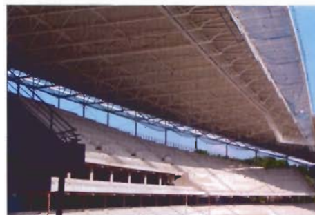
Für die leichte UK wurden Stahltrapezprofile von 0,88 als dünnstes und 1,25 mm als dickstes Profil verwendet.
