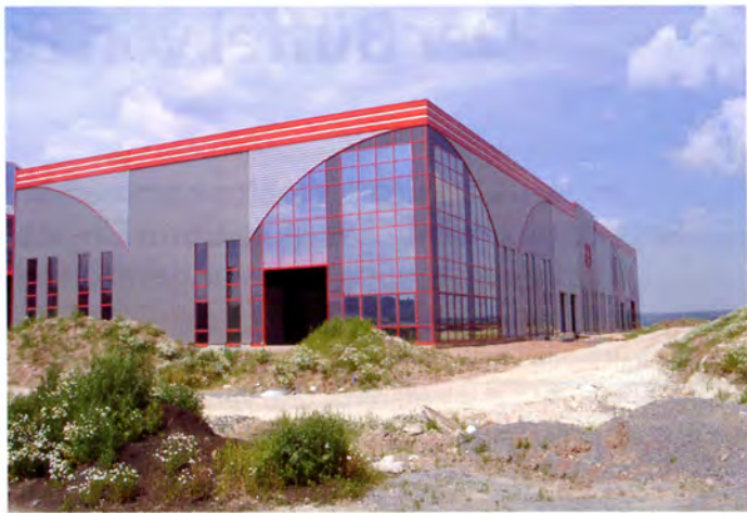
FOTOS: HAMMERSEN ELEMENTBAU
