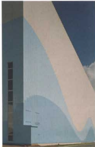
Bild 2. Die Fassade, bestehend aus einer horizontalen Kassettenwand mit innenliegender Wärmedämmung und außenliegenden Trapezblechen, trägt die Hausfarben des Unternehmens
