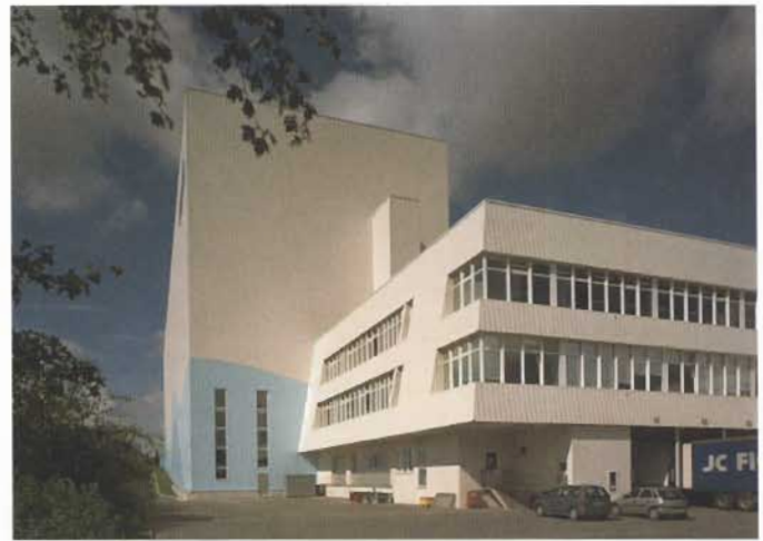
Bild 1. Das neue Hochregallager des Playmobil-Herstellers geobra Brandstätter GmbH & Co. KG in Diethenhofen
