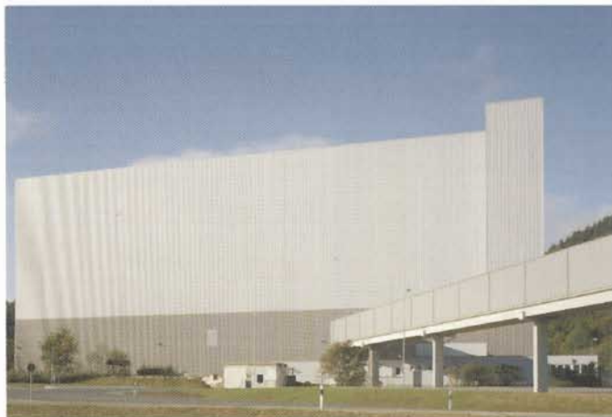
Bild 2. Die insgesamt 210 m lange Förderbrücke zwischen Lager und Produktionsgebäude, ummantelt mit Trapezblechen (Fotos: Hammersen Elementbau)
