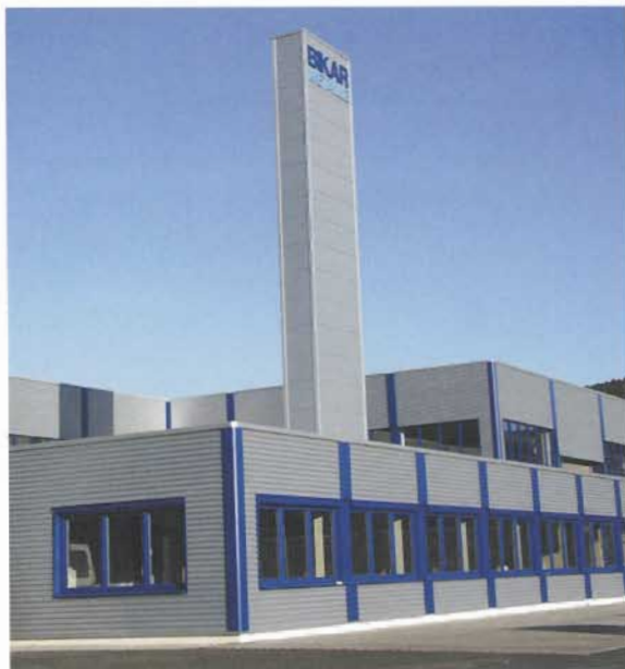
Bild 2. Blaue Lisenen verdecken die Schnittstellen der Wellprofile (Fotos: wib Industriebau)
