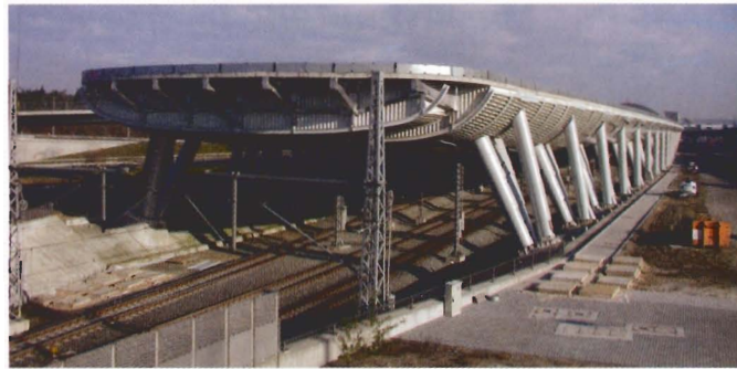
Bild 2. Bugansicht: Die Zwischenbinder bestehen aus 15 einzelnen Radien
