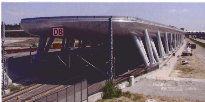
A14 Bild 1. ICE-Fernbahnhof am Flughafen Frankfurt/M.: Verkleidung aus Trapezprofilen mit exaktem Fugenverlauf
