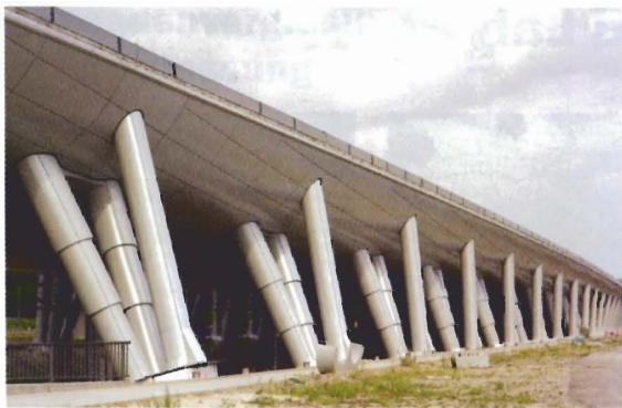
Bild 4. Stahlstützen, mit einer Brandschutzisolierung ummantelt, an der Südseite des Bahnhofs
