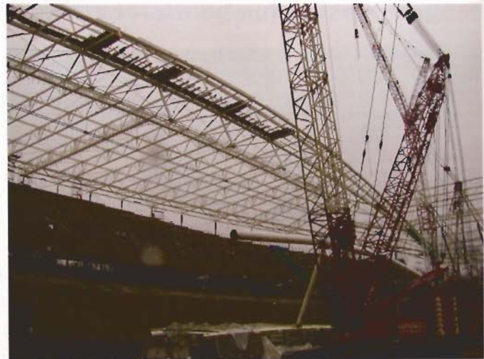
Bild 3. Für die leichte Unterkonstruktion wurden Stahltrapezprofile von 0,88 mm als dünnsstes und 1,25 mm als dickstes Profil in den Endfeldern verwendet (Fotos: Radabau)
