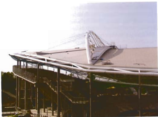
Bild 1. Die Oberflächen des Tribünenendaches sind gewölbt , was bei der Montage der Trapezprofile exakte Verlegepläne erforderte
