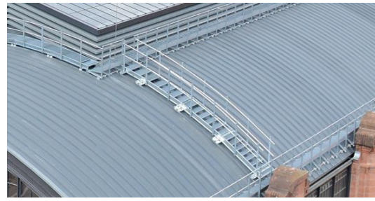
Bild 2: Begehbarkeitseinrichtungen in Kombination mit Absturz sicherungssystem
